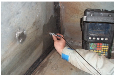
(超音波探傷試験 状況写真)
