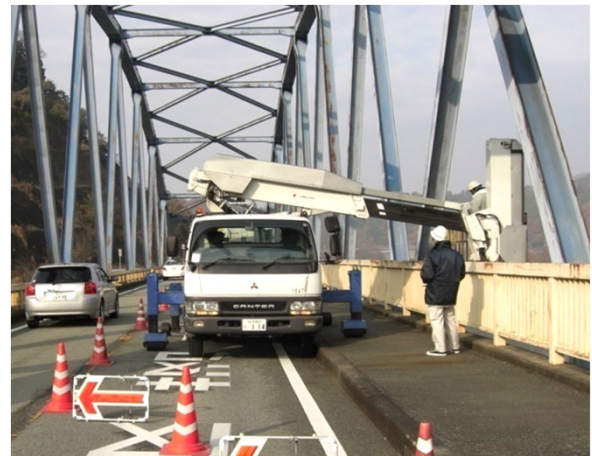
【 橋梁点検車使用による点検業務 】
