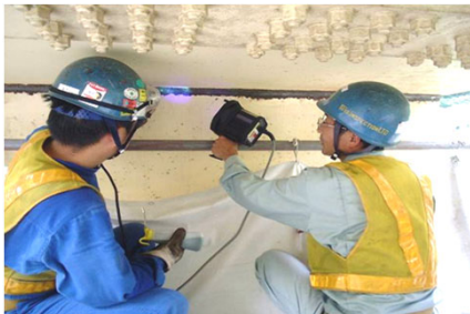
(磁気探傷試験 状況写真)
