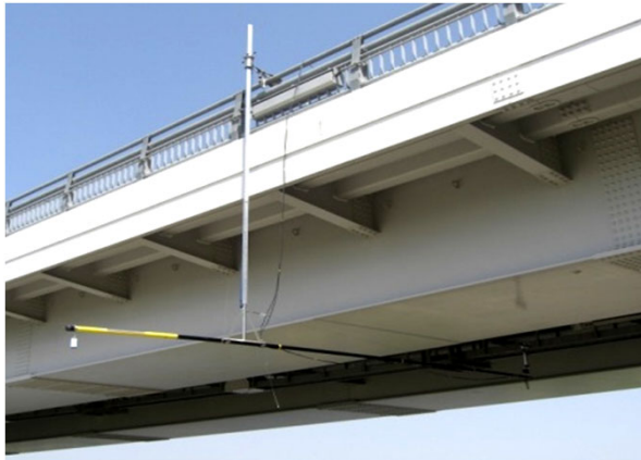
【 橋梁点検カメラ使用状況 】
