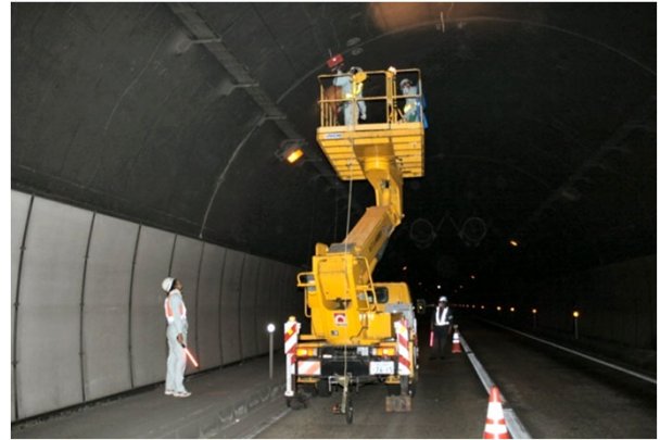
調査状況【覆エレーダ調査】
